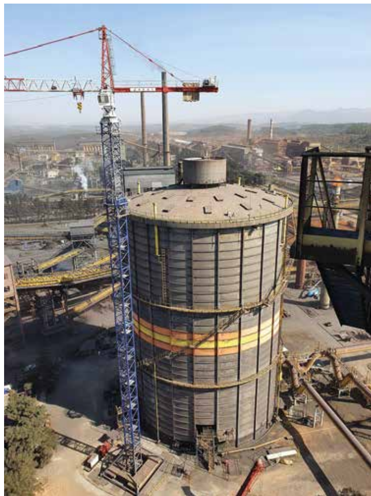
Vista aérea do Gasômetro GCO, em Ouro Branco-MG.
